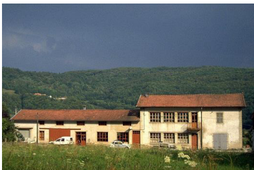
Usine de tournerie Bourbon, Ravilloles
