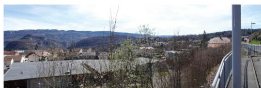
Route en balcon avec trottoir à ne pas se laisser s'obturer
