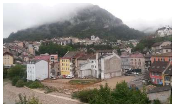
Ci-dessus : photos avant et après travaux
