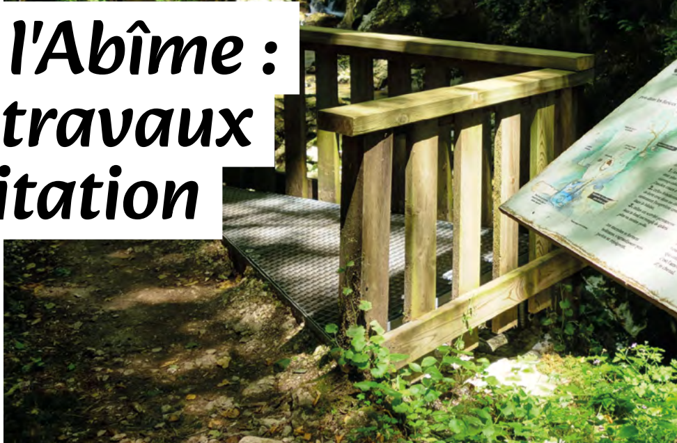
Réfection des structures et panneaux d'interprétation.
